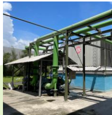
Pembangkit Listrik tenaga sekam, Palembang. Memproses 120 ton sekam menjadi listrik 3MW.
