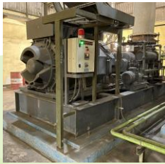
Pembangkit Listrik tenaga sekam, Palembang. Memproses 120 ton sekam menjadi listrik 3MW.
